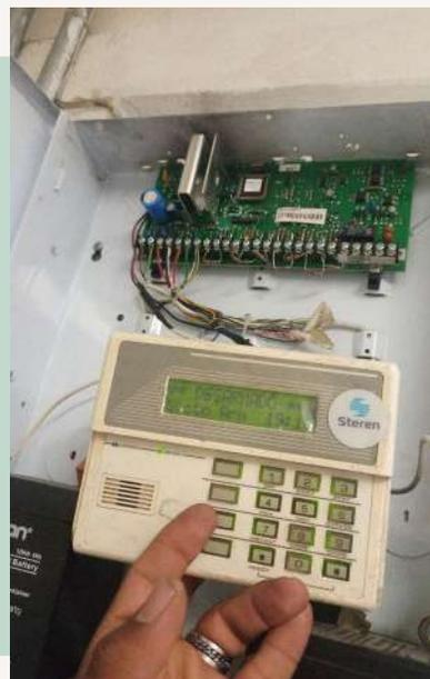
La alerta sísmica, colocada en distintas áreas del plantel, requiere de revisión periódica para ofrecer un funcionamiento adecuado y logre brindar el mayor tiempo de oportunidad ante la llegada de un sismo, por lo que personal especializado hace los trabajos y ajustes correspondientes para el aviso oportuno y de alerta en caso de un fenómeno telúrico.
